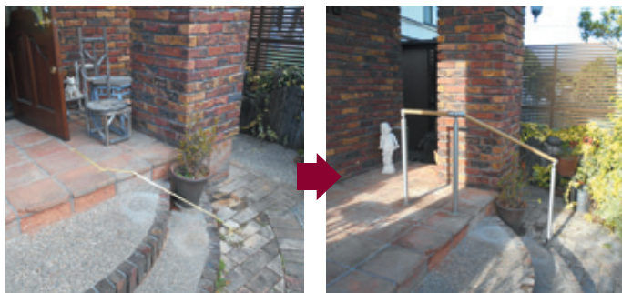
外階段手すり
