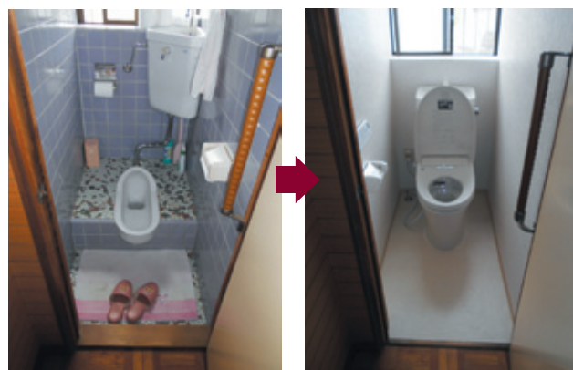
和式便器から洋式便器へ交換
