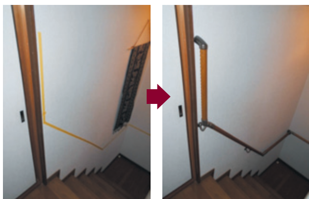
内階段手すり
