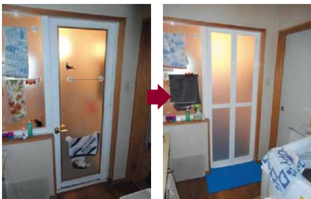
浴室扉交換(折れ戸へ)
