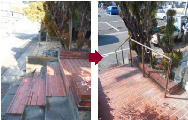
外階段手すり
