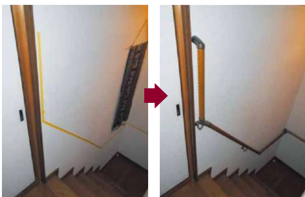
内階段手すり
