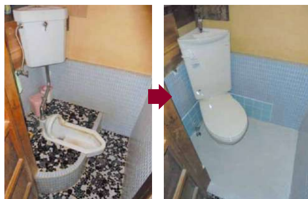
和式便器から洋式便器へ交換
