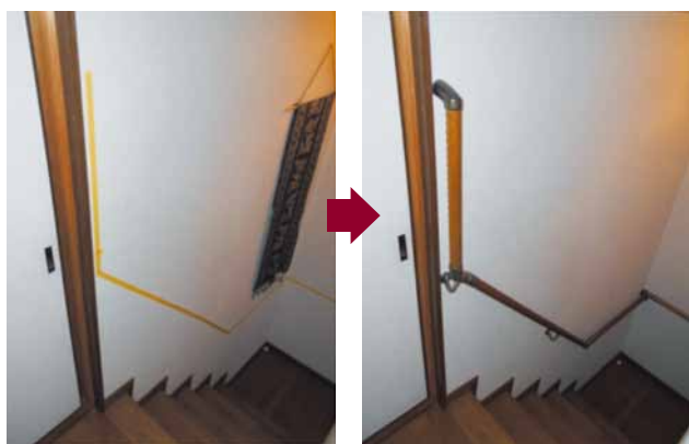
内階段手すり
