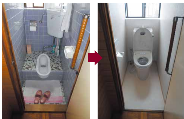
和式便器から洋式便器へ交換
