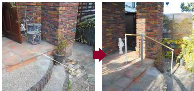
外階段手すり
